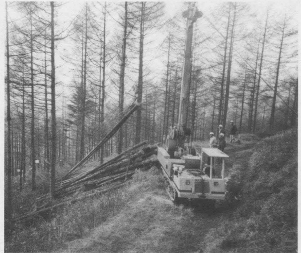
写真-2 タワーヤーダ集材
