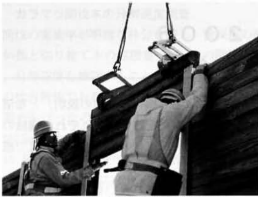
写真-2 カラマツ製遮音板の取り外し
