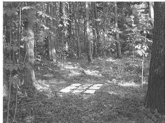
写真-2 アカマツ林内への敷設状況
