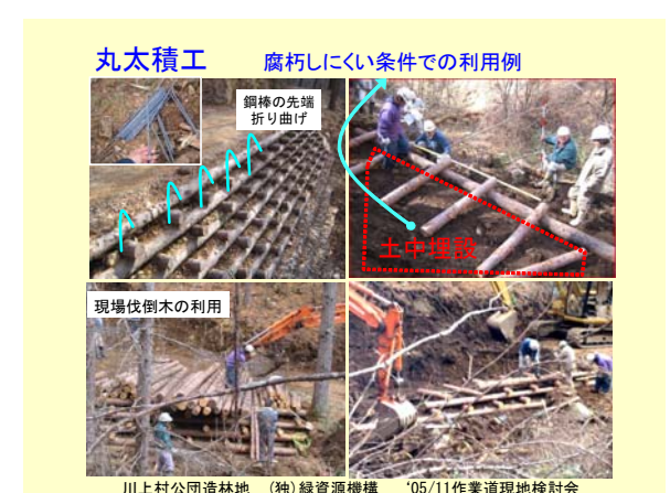
図-13 丸太積工
