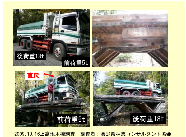
図-10 丸太橋の調査（長野県林業コンサルタント協会）
