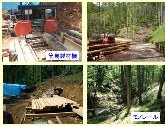
図-15 現場発生材の活用事例
