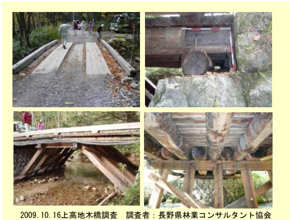
図-9 丸太橋の構造
