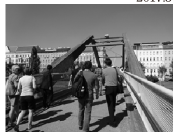
写真4 エルドバーガー橋
