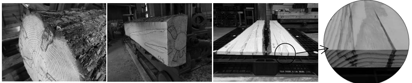
写真 2 材面の変色の様子
