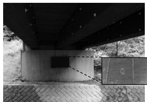
写真-1 腐朽モデル試験体
