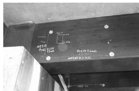
写真-2 右岸 No. 4 プロット
