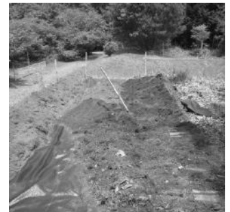
写真-8 防草シートの上に15cm厚程度土を載せる
