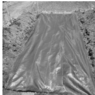
写真-7 防草シートを張る
