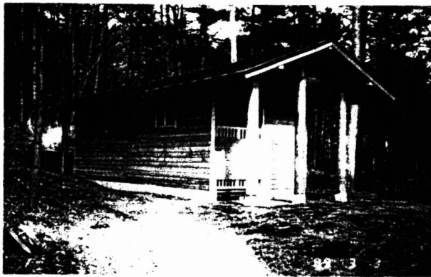
写真-3 完成 外壁は木材保護着色剤(キシラデコール)を塗布
