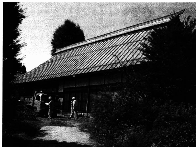
写真-1 再生工事前の古民家の全景
