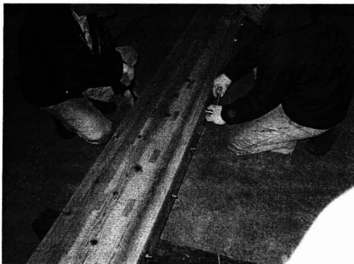
写真-8 ボルト締め
