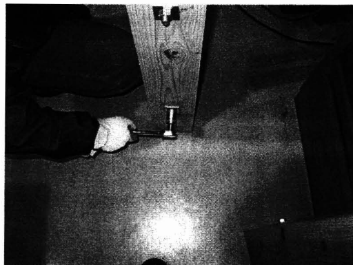
写真-10 トルクレンチでの締め付け
