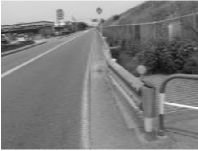
写真1 1号型の設置状況
