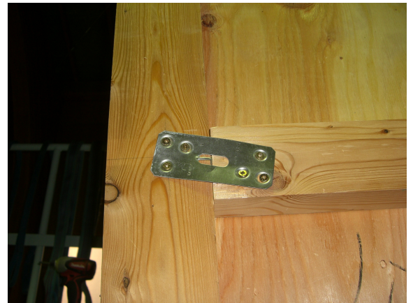
写真 5-1 柱・横棧接合部金物
