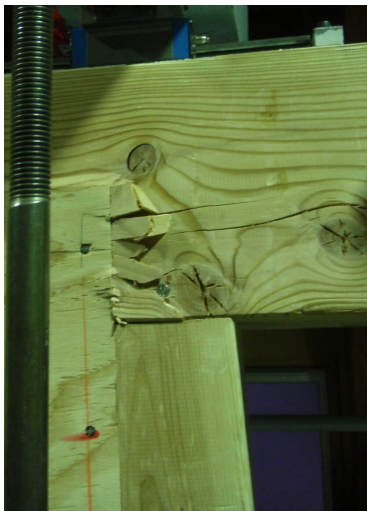
写真 6-1 A-2 試験体 (梁破壊部)
