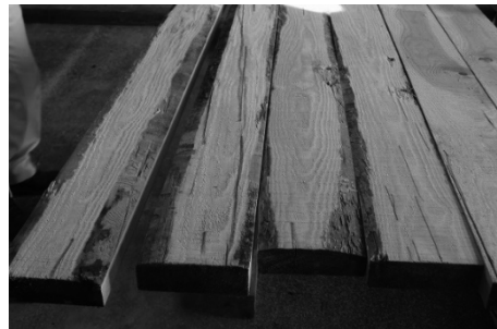
写真4-10 製材時に既に存在する表面割れ
