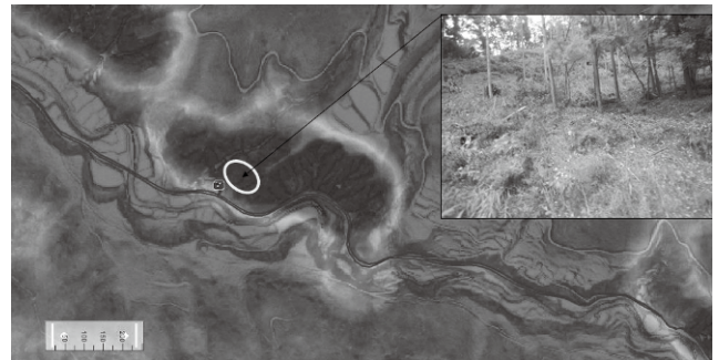
図 3-2 面的に斜面侵食が発生
