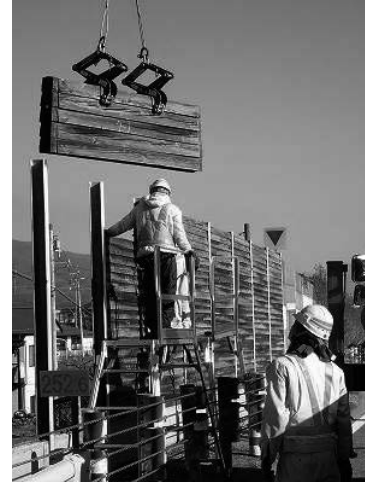
写真-2 30年経過した遮音壁の交換
