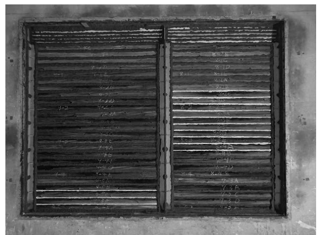
写真-11 シーリング処理した遮音壁
