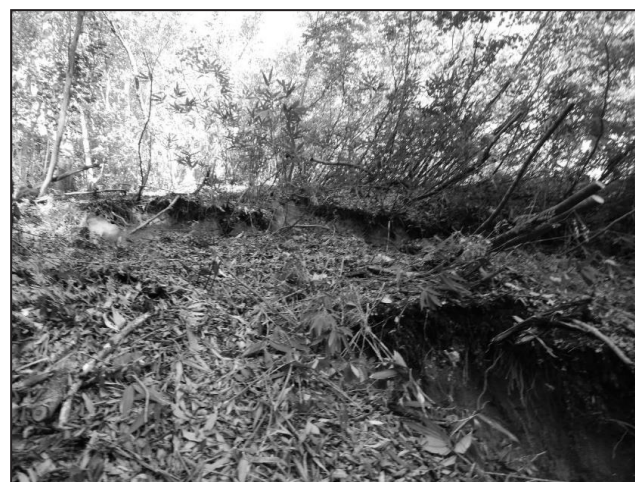
写真-3 現地状況 (地すべりブロック内の亀裂)
