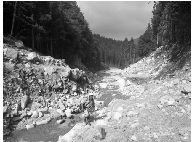
写真-1 梨子沢中流域の河床洗掘状況
