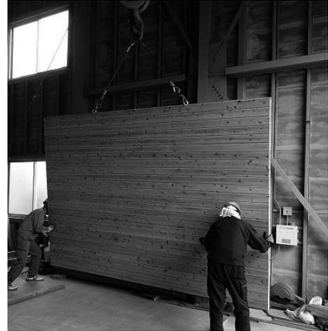
写真-11 一体化した遮音板(5枚の遮音板)
