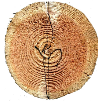
写真-3 割裂線の例
