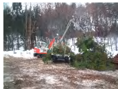
写真 3-8 土場への荷卸状況
