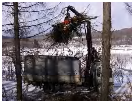
写真 3-14 トラックへの積込み
