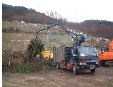
写真 3-11 トラックからの荷卸状況
