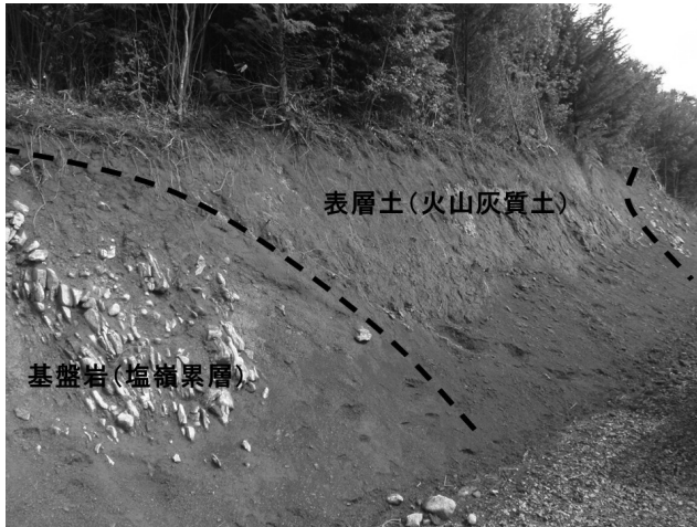
写真-4 作業道法面で観察した地質構造
