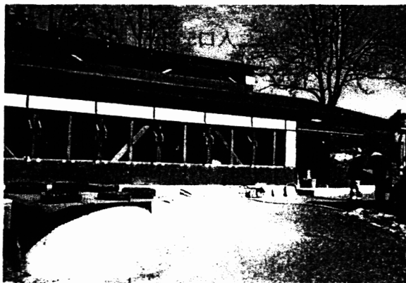
写真-1 カラマツ間伐材を用いた「低コスト畜舎標準設計基準」に基づく木造畜舎(下伊那郡泰阜)
