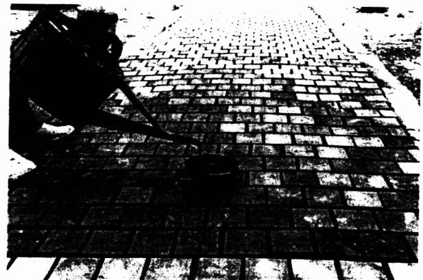
写真-2 加熱溶解アスファルトの目地への流しこみ
