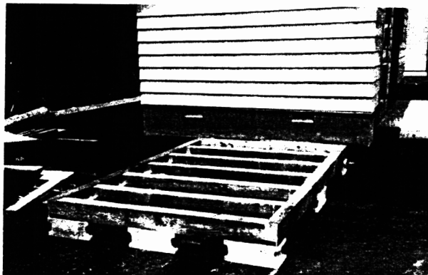
写真-2 床組の完成 ジョイント部は釘と金物を併用する
