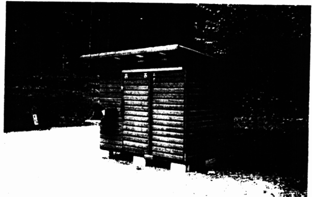
写真-7 軸組タイプのストックハウス(1.5坪)の完成 防腐塗装は木材保護着色剤による
