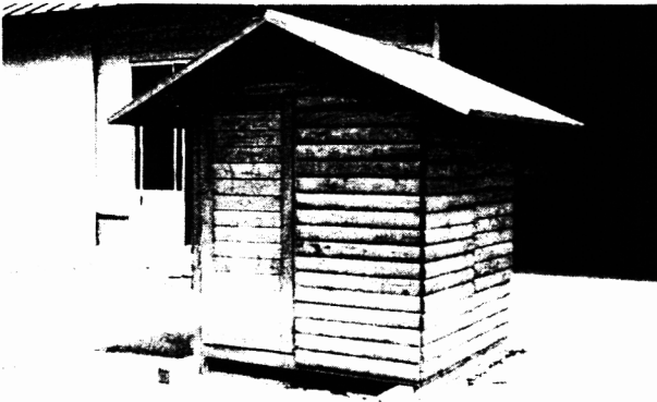
写真-13 パネルタイプのストックハウス(1坪) 木材保護着色剤を塗付して完成
