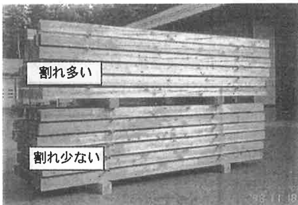
写真1-5 材面割れの発生状況(カラマツ)
