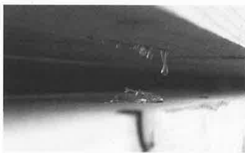
写真10 カラマツ桁材のヤニ壺から垂れるヤニ
