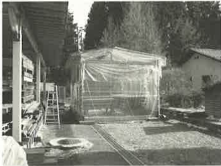
写真-5 二重張り構造のビニールハウス (右) と屋根付き天乾燥場 (左)
