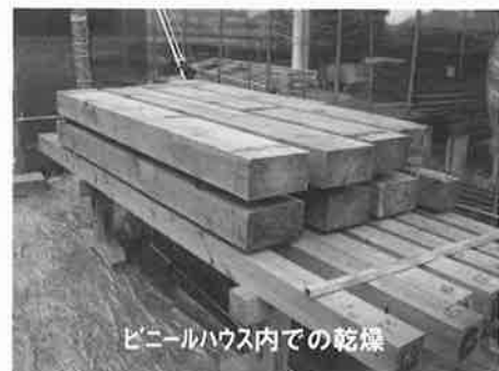
写真-4 ビニールハウス内の2m桁材
