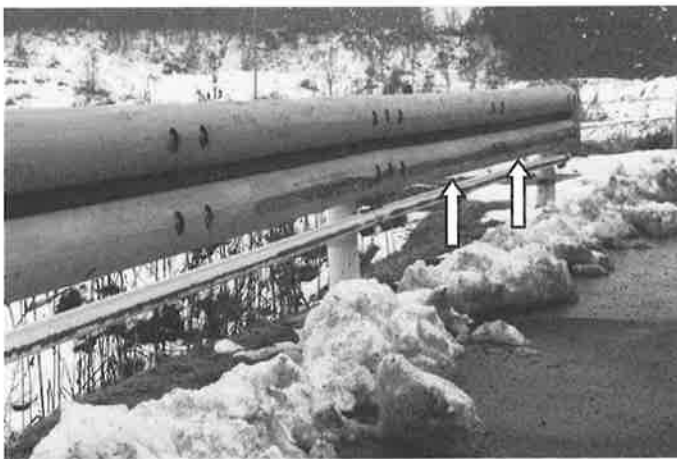
写真-3 木製横梁への自動車の接触痕と、曲げ破壊による亀裂(矢印)
