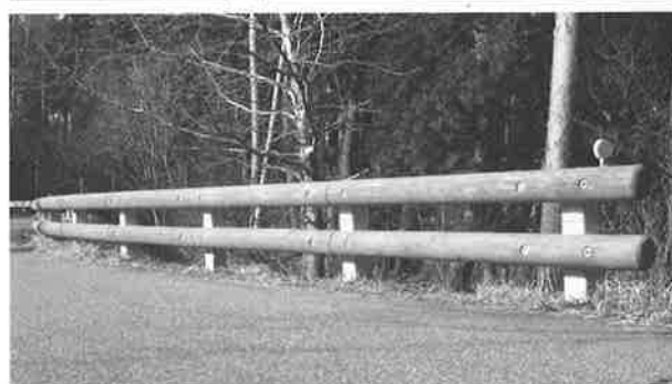
写真-1 信州型木製ガードレール （上から1，2，3号型）
