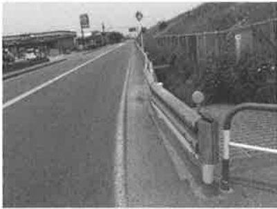
写真1 1号型の設置状況
