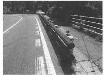
写真3 3号型の設置状況
