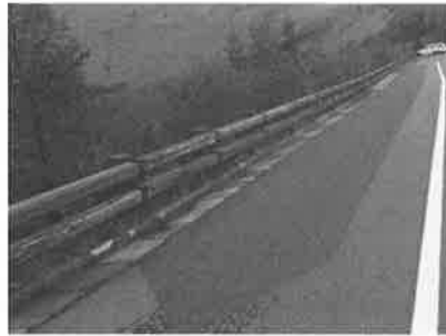
写真2 2号型の設置状況
