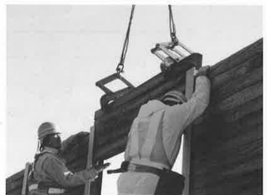
写真-3 カラマツ製遮音板の交換
