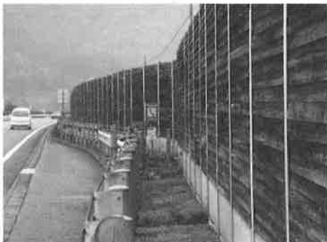
写真-1 設置後約20年経過のカラマツ製遮音壁
