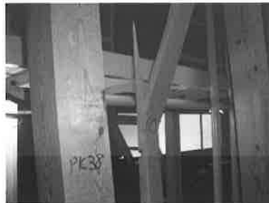
写真 3-2 gf2 試験体圧縮側筋かい
