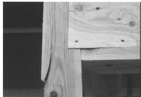
写真 6-3 B-1 試験体 (柱破壊部)
