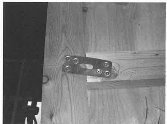
写真 5-1 柱・横棧接合部金物
