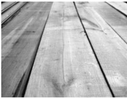
写真 1-7 髓を含んだ材の割れ (髓割れ)
