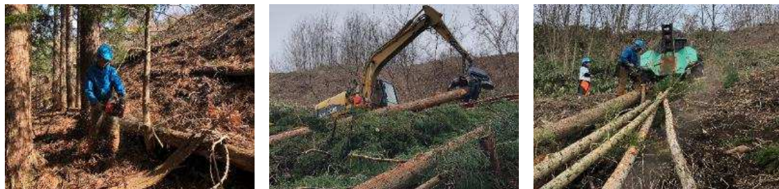
（地区要望により支障となっている森林の整備施工中）
