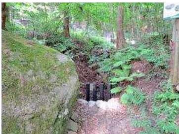
（暗渠排水路改良）
