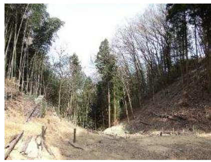
（令和4年度施工後）
