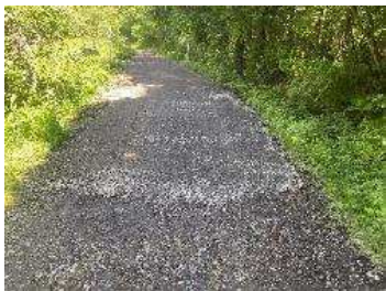
（林道路盤実施後）
