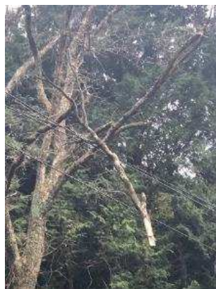
（枯れ枝が高圧電線に架かる様子）
