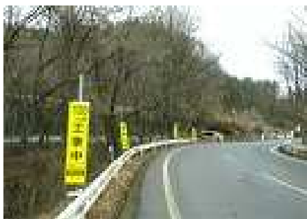
（国道403号沿線伐採作業①）
