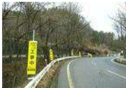
(国道403号沿線伐採作業①)
