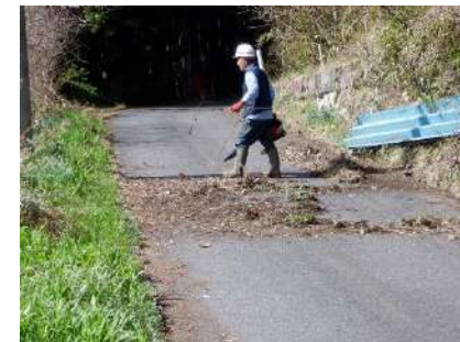
側溝の清掃及び 路面の落枝・落葉の除去
