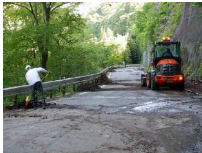
側溝の清掃及び 路面の落枝・落葉の除去
