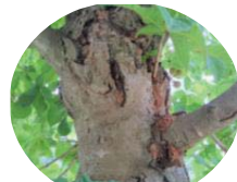
【被害の状況（トチノキ）】
