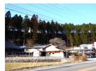
防災・減災のための里山整備 (集落上部の間伐)
