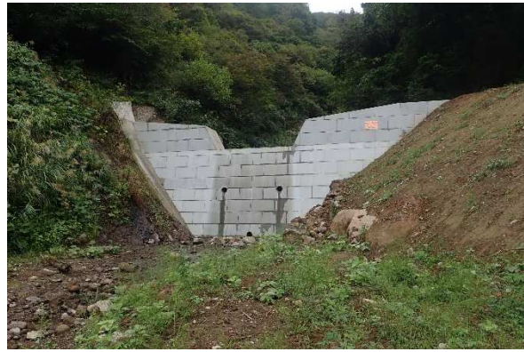
治山ダムの設置状況
