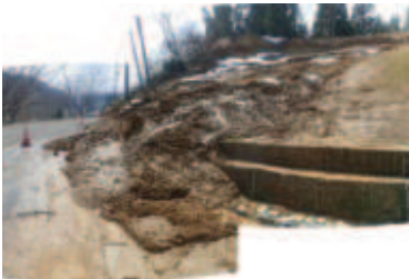
【応急対策（大型土のう設置）】
