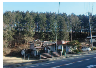
防災・減災のための里山整備（集落上部の間伐）
