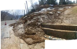
【応急対策（大型土のう設置）】
