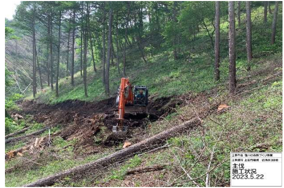
② バックホーによる作業道開設作業
