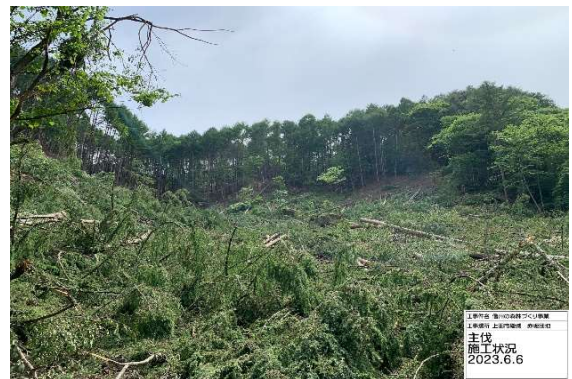
④ チェンソーによる伐倒作業
