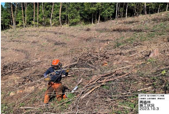
⑦ 主伐後の地拵え作業
