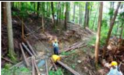
簡易ウインチを利用した搬出作業 (伊那市長谷溝口 溝口里山創り隊)
