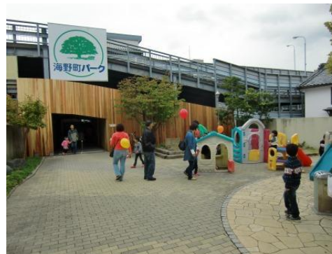
公園と駐車場の間に設置された木塀
