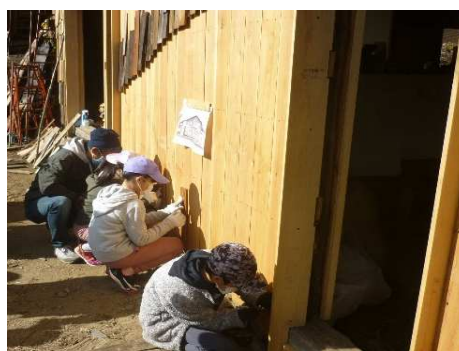
県産材を活用した建物の外装木質化
