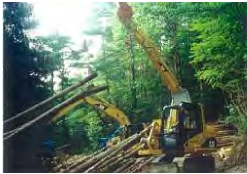
高性能林業機械による搬出間伐
