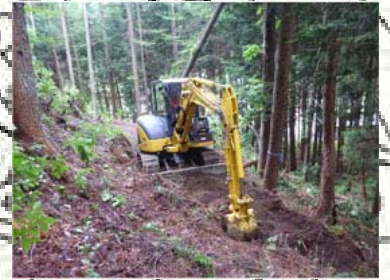
森林作業道整備
