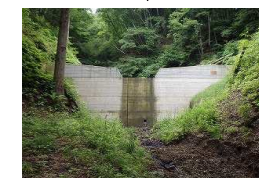
竣工から3年後
