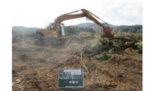
伐採・造林一貫作業(地拵)
