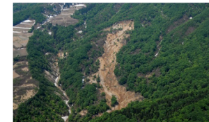
飯山市井出川 災害発生状況
