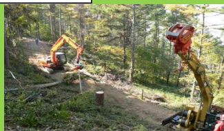
スイングヤーダ木寄せによる架線系システム
