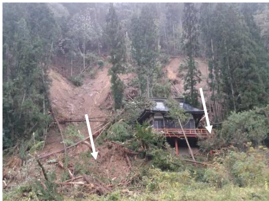
山腹崩壊: 鹿教湯(上田市)
