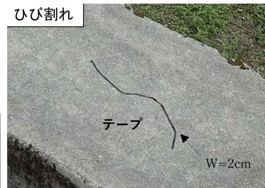
疑似変状マーカーを用いた新規変状箇所の例
